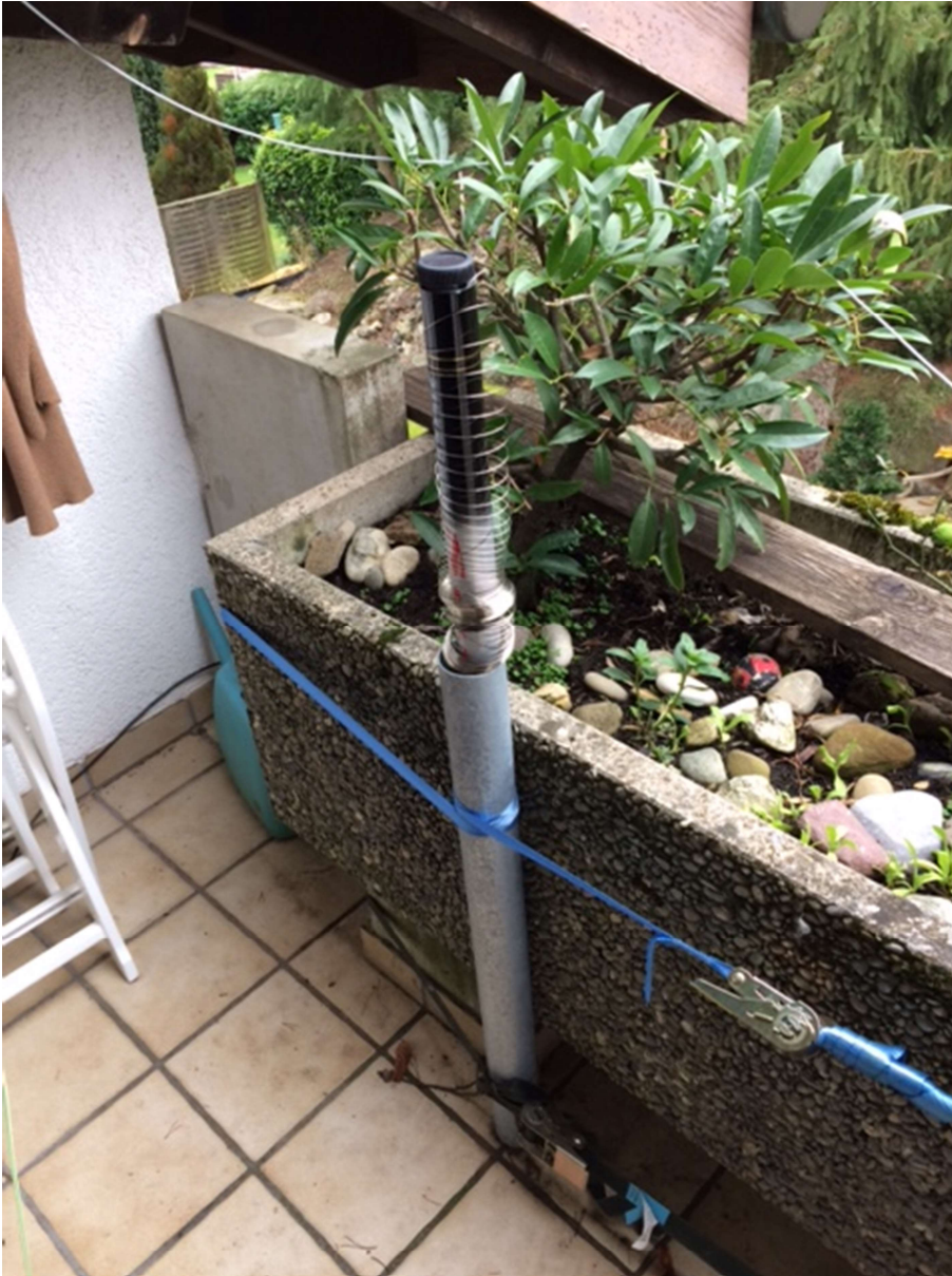
Abbildung 2 Helical eingefahren im Montagerohr
